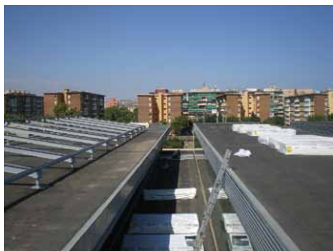
Reparació i impermeabilització de la coberta del Centre Esportiu Maresme
