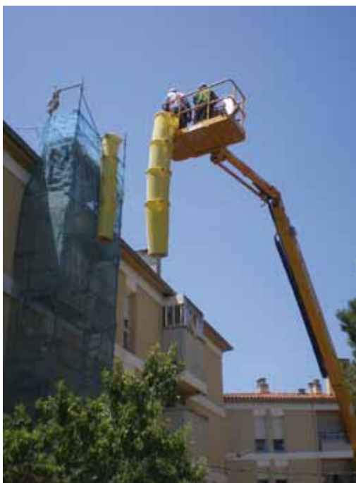
Rehabilitació d'una coberta en edifici plurifamiliar, fase única, Gavà
